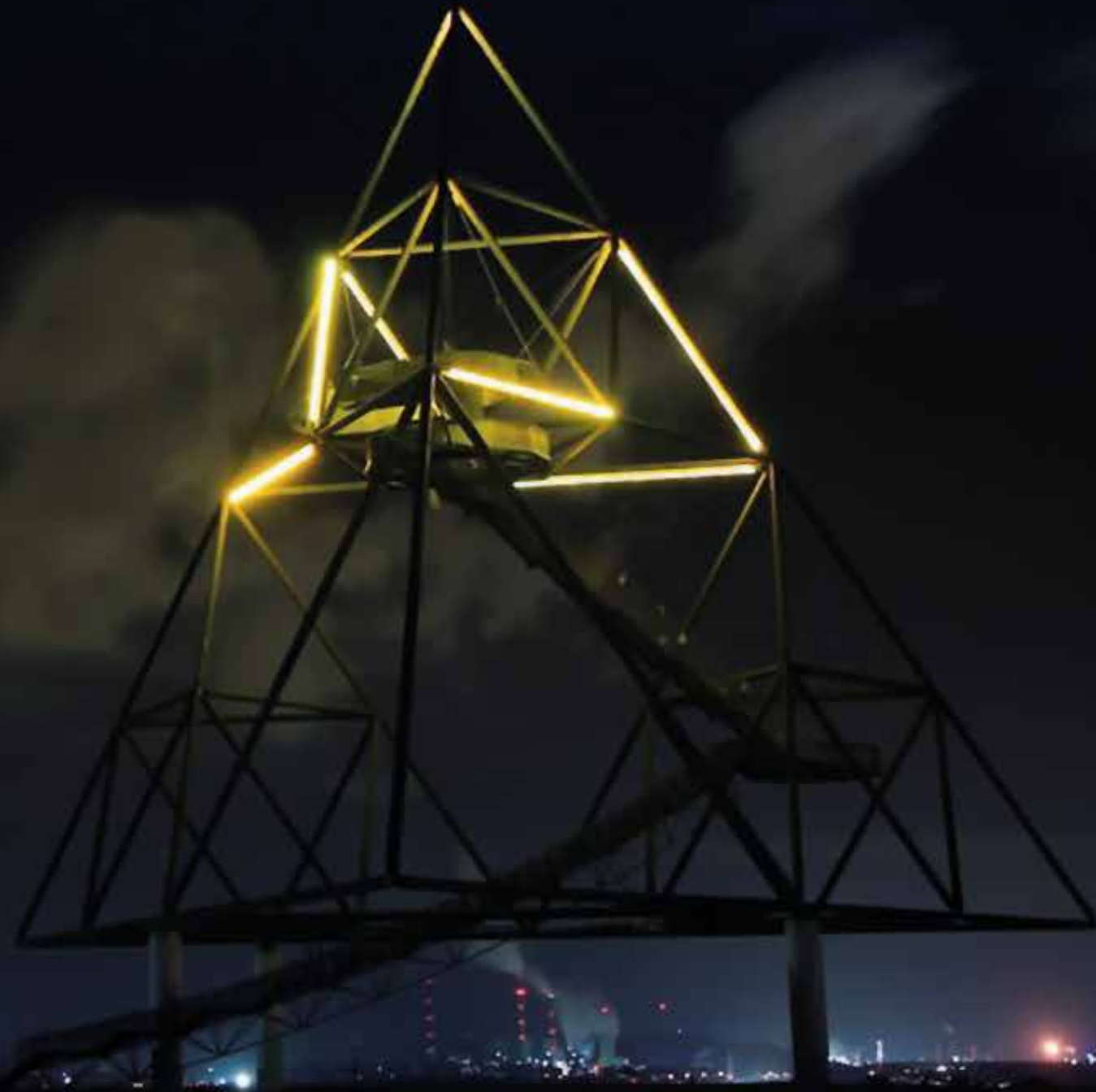
Das Haldenereignis Emscherblick, kurz Tetraeder, ist eine begehbare Aussichtsterrasse in Form einer dreiseitigen Pyramide auf der Halde Beckstraße im Bottroper Stadtteil Batenbrock.
